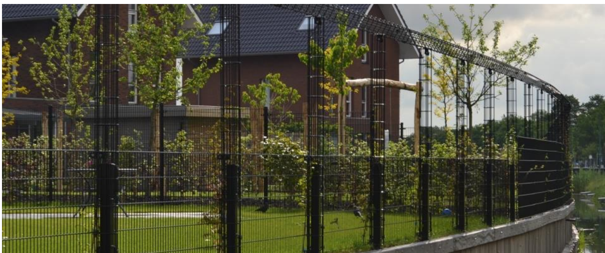
Remion stalen rasterpergola; deze open staalconstructie vormt een goede geleiding van klimplanten; onbegroeide situatie vlak na de constructie van de pergola.
